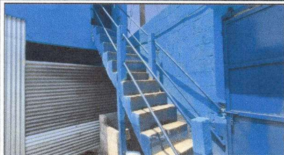
FOTO 1: Sustrucción de barandas de metal.
