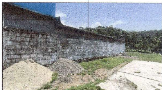
FOTO 10 : Repello en muro
