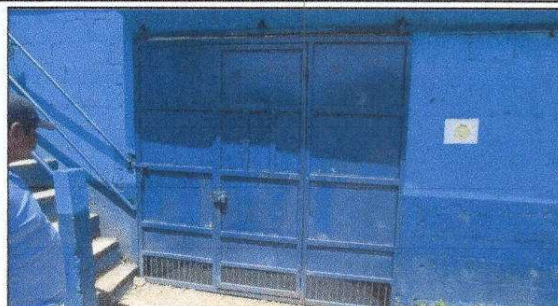
FOTO 8: Fabricación e instalación de portón de metal de ingreso
