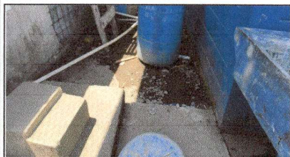
FOTO 3: Reparación de planchas de concreto de patio
