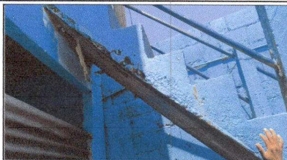
FOTO 2: Sustrucción de barandas de metal.
