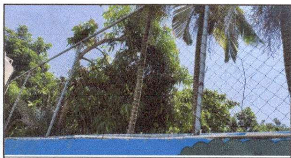
FOTO 5: Reparación de tubo hg y malla galvanizada
