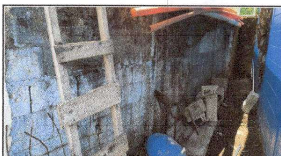
FOTO 4: Reparación de planchas de concreto de patio
