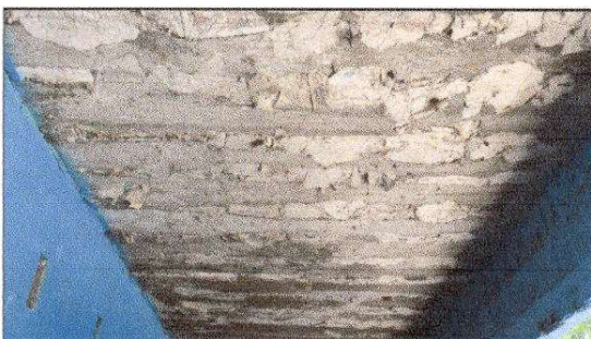
FOTO 9: Repello en muro
