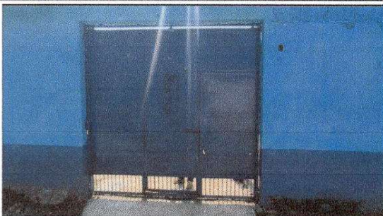
FOTO 7: Fabricación e instalación de portón de metal de ingreso
